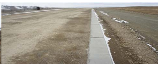
Замын суурин ажил хийгдсэн байдал
