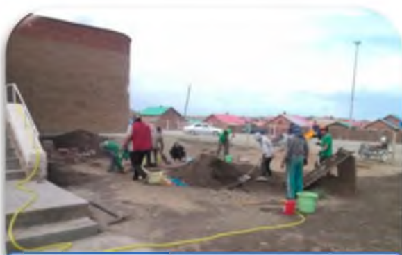
Зураг 3: Нийтийн эзэмшлийн талбай тохижуулж буй явц
