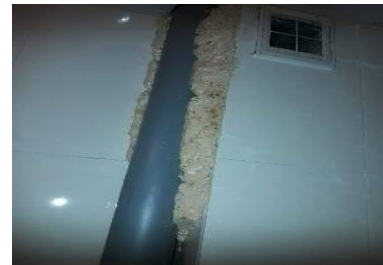
Зураг №5 Агааржуулалтын хоолойд хөөсөнцөр шахсан байдал
