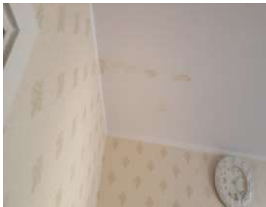
1-14 байрны 2 блокын дээврээс ус орсон байгаа байдал
