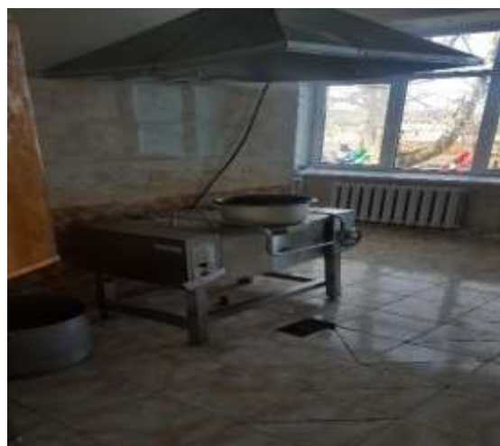
3-р цэцэрлэгийн гал тогооны өрөөний усны хаялгыг сайн гаргаагүй шалны зориулалтын плита наагаагүй
