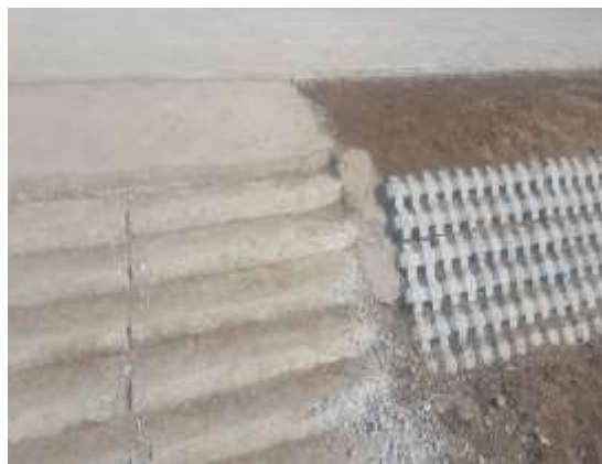
17-р сургуулийн гадна газрын теннисний талбайн шатны хоёр тал хагарч, бутарсан байдал
