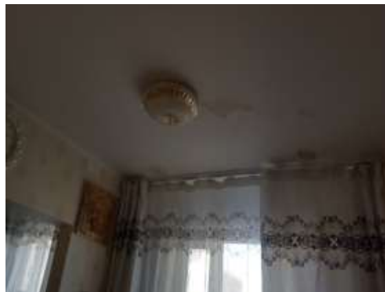
1-14 байрны 2 блокын дээврээс ус орсон байгаа байдал
