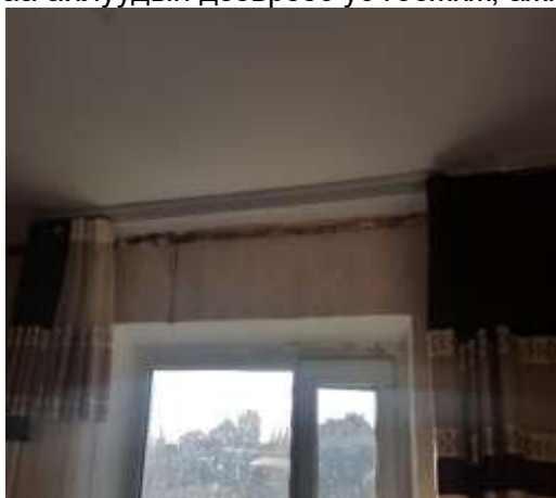
4-10 байрны 3 блокын дээврээс ус орсон байгаа байдал
