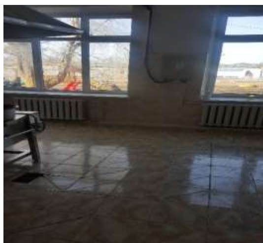
3-р цэцэрлэгийн гал тогооны өрөөний усны хаялгыг сайн гаргаагүй шалны зориулалтын плита наагаагүй
