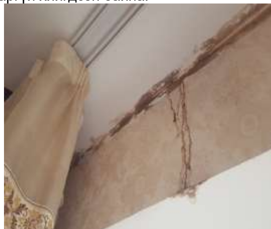
4-10 байрны 3 блокын дээврээс ус орсон байгаа байдал
