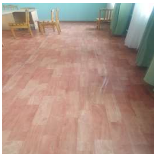
3-р сургуулийн шаланд наасан хулдаас товойж, хууларсан байгаа байдал
