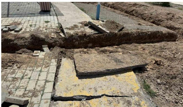
Зураг 2 Шугам сүлжээний нүх ухаад орхигдсон байдал
