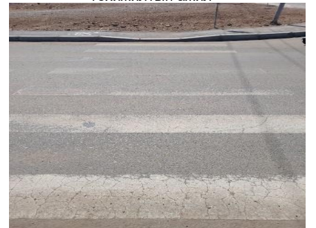
НД, Замын тэмдэг тэмдэглэгээ сэргээх ажил
