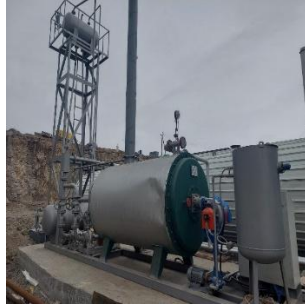
Тайлбар: СХД, “Асфальтын үйлдвэр барих, тоног төхөөрөмж нийлүүлэх ажил”, суурийн ажил төлөвлөөгүйгээс суурийн ажил ажил хийгдээгүй, стандартын дагуу гүйцэтгээгүй.
