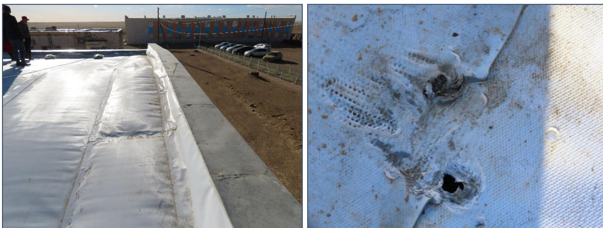
Зураг 1. Төгрөг сумын ЕБС-ийн дотуур байрны дээврийн засвар
