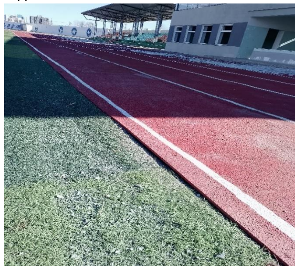
Аймгийн Баяр наадмын талбайн гүйлтийн замын амлагааг тэгш хэмгүй, гүйлтийн замыг овон товон хийсэн байдал
