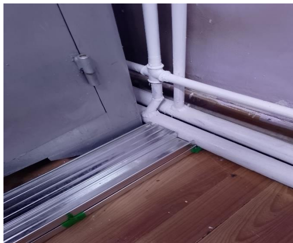
Халаалтын хоолойнуудын холболтуудыг холбох хэрэгсэл ашиглалгүй шууд гагнаж холбосон байдал
