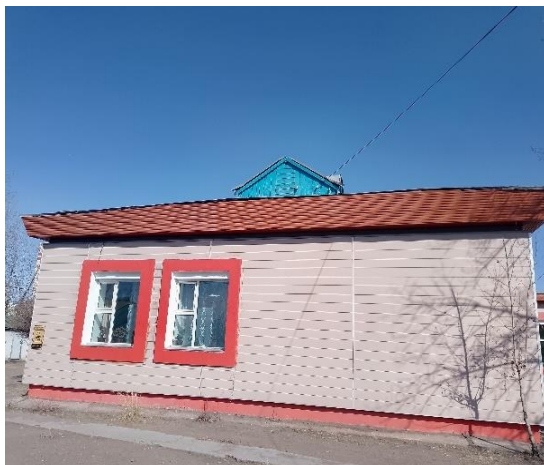
Мөрөн сумын 8 дугаар цэцэрлэгийн дээврийн гарнизны хэсэг болон гадна сайдинг хийсэн байдал
