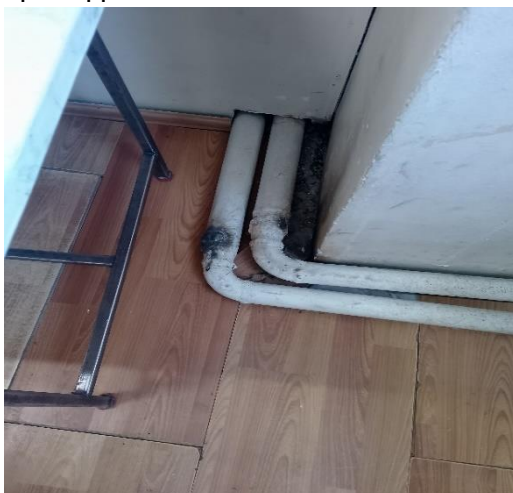
Халаалтын хоолойнуудын холболтуудыг холбох хэрэгсэл ашиглалгүй шууд гагнаж холбосон байдал
