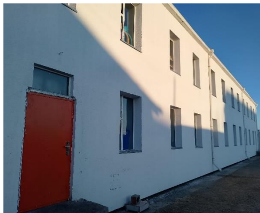
Хатгал тосгоны Ерөнхий боловсролын бага сургуулийн засвар, дулаалга ажлыг гүйцэтгэхдээ газардуулга хийгээгүй байдал
