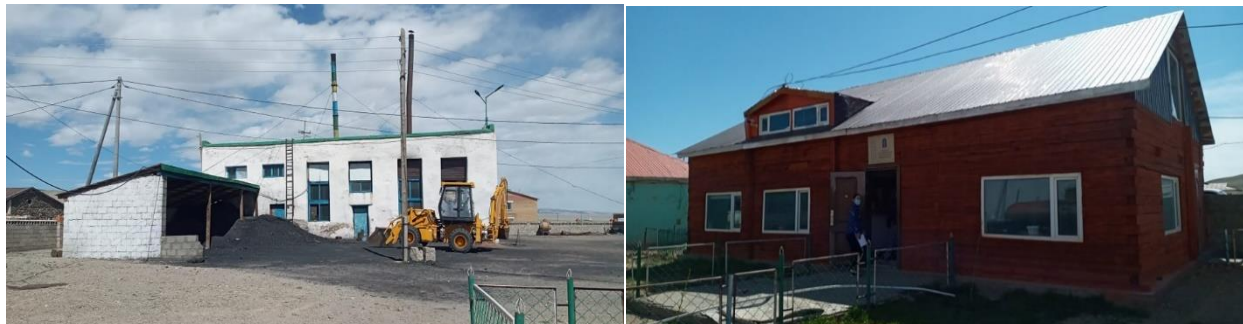
Зураг №3. Эрдэнэ эрчим хүч ОАНААТҮГ-ын гадна байдал /Зуухны барилга, нүүрсний саравч, конторын барилга/
