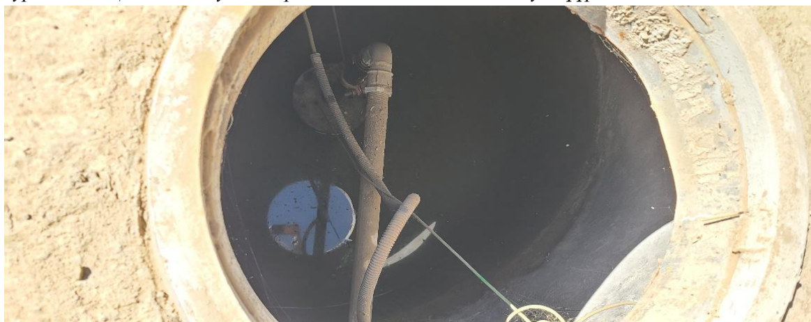
Зураг №16 /Цахилгааны утас харагдаж байгаа байдал, мөн ус дүүрсэн байна/
