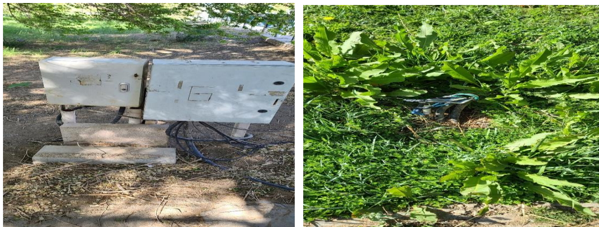
Зураг №17 /Худгийн болон гэрэлтүүлгийн цахилгааны ерөнхий самбар , цахилгааны утасны аюулгүй ажиллагаа алдагдсан ус, хөрснөөс тусгаарлах сүвлэгч хийгдээгүй байна/
