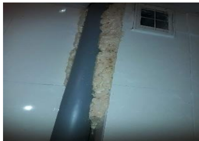
Зураг №5 Агааржуулалтын хоолойд хөөсөнцөр шахсан байдал
