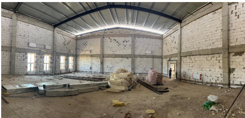
Барилгын ажлын өрлөг, өрөө тасалгааны зохион байгуулалт, цахилгаан, дулаанд холбох ажлууд бүрэн дуусч, гадна тохижилт, дотор заслын ажлууд үлдсэн байна.
