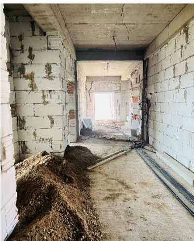
Барилгын ажлын өрлөг, өрөө тасалгааны зохион байгуулалт, цахилгаан, дулаанд холбох ажлууд бүрэн дуусч, гадна тохижилт, дотор заслын ажлууд үлдсэн байна.
