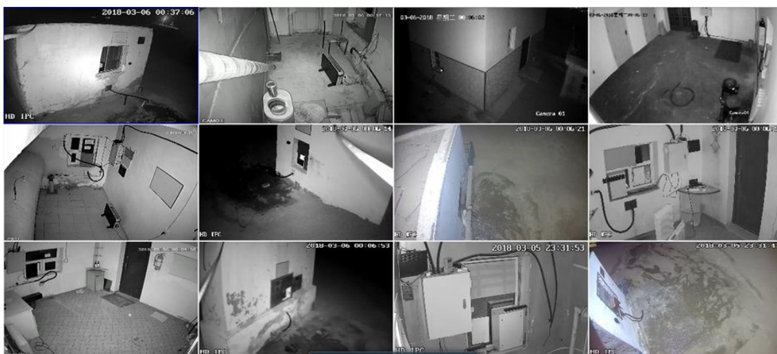
Зураг6. Усны эх үүсвэрийн автоматжуулалт
