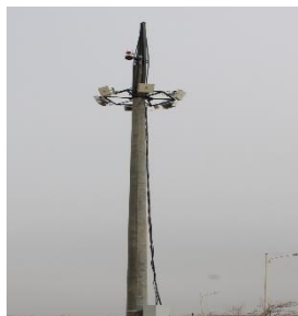
Бодит байдал-цамхагт гэрэлтүүлэг, дүрс ажиглалтын систем
