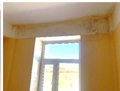
Соёлын төвийн барилга ашиглалтын явцад агааржуулалттай холбоотой асуудал үүссэн байна.
