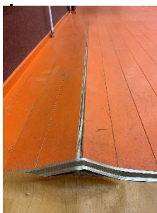
Соёлын төвийн барилга ашиглалтын явцад агааржуулалттай холбоотой асуудал үүссэн байна.
