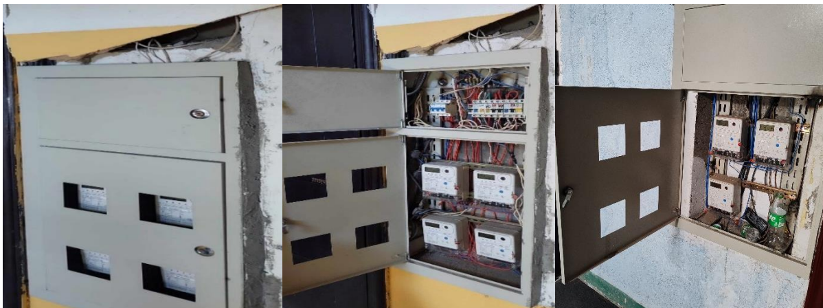
Зураг №2: 1,4,5,7,8,9,10,11,12,15 байранд хийсэн цахилгааны самбар онгорхой, зай завсрыг битүүмжлээгүй улсын комиссын үүрэг даалгаврын биелэлт хангагдаагүй байхад хүлээн авсан байна.
