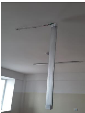
Өрөөнүүдийн гэрэлтүүлэг салсан, Усны хаялга дагаж мөсжилт үүссэнээс барилгын хана норсон
