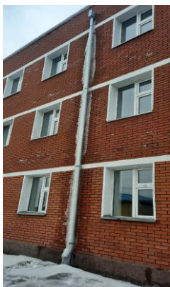
Өрөөнүүдийн гэрэлтүүлэг салсан, Усны хаялга дагаж мөсжилт үүссэнээс барилгын хана норсон
