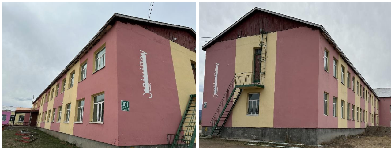
“Сэлэнгэ сумын сургуулийн дээврийн карниз, усны хаялаг хийгдээгүй”
