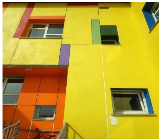
Гадна пасадны будаг хууларсан байдал
