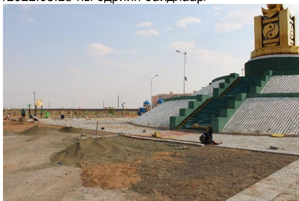
Зураг №5 Замын-Үүд сумын “Соёмбот цогцолборын засвар шинэчлэлт” ажил хийгдэж байна. /2022.05.18-ны өдрийн байдлаар/
