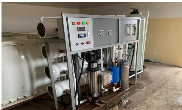
Ус цэнгэгжүүлэх төхөөрөмж Халхгол, Гурванзагал суманд тоног төхөөрөмж ашиглалтгүй байна.
